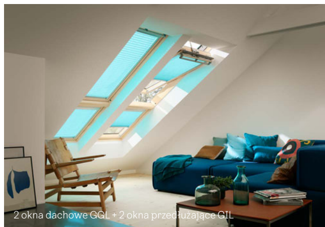
2 okna dachowe GLL + 2 okna kołankowe VFE
